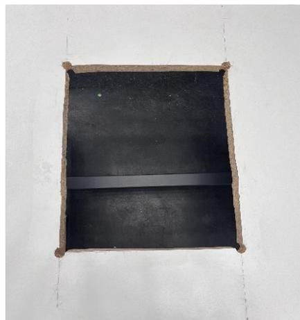
3. Insérer la hotte munie de ses cornières métalliques, jusqu'en applique sur la table. Au besoin, ajuster les dimensions du trou avec un léger meulage.
