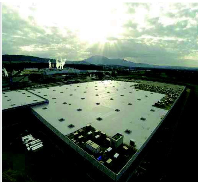
Aldi centre logistique 50000m2 TPO Membrane, Suisse
