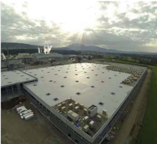
Aldi centre logistique 50000m2 TPO Membrane, Suisse
