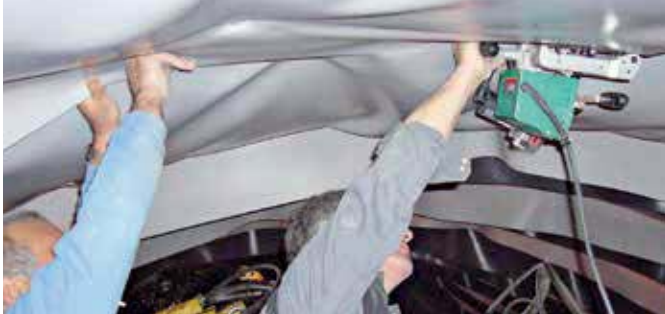
COMET à l'œuvre dans les tunnels ...
