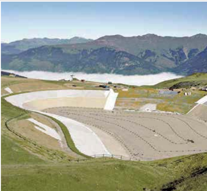
Réservoir d'eau HDPE 2.0 mm
