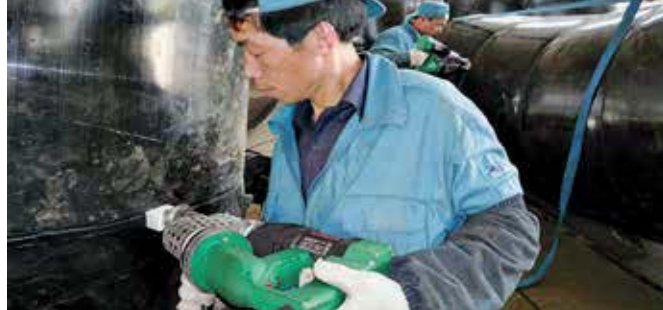
La FUSION 2 à l'oeuvre pour la construction de réservoirs.
