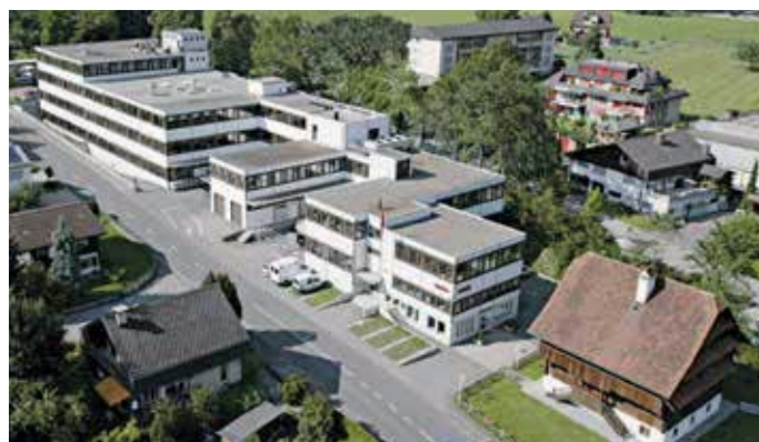
Leister Technologies AG, Production, Kaegiswil, Suisse
