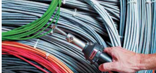
Pose d'un raccord fretté avec le modèle HOT JET S et réflecteur à tamis emboîtable.
