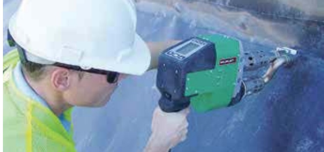
La puissante WELDPLAST S4 à l'œuvre.
